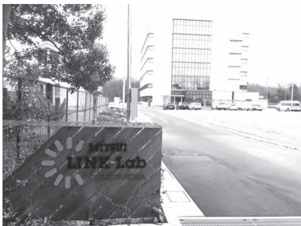
写真 1 三井リンクラボ柏の葉 1 の外観
