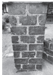
図6 日鉱斯道館の門柱に使用されているカラミ煉瓦 5)
