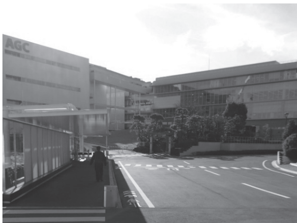
写真1 AGC横浜テクニカルセンター外観
