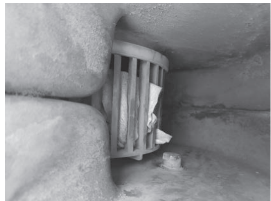
写真 2 排風機への異物混入
