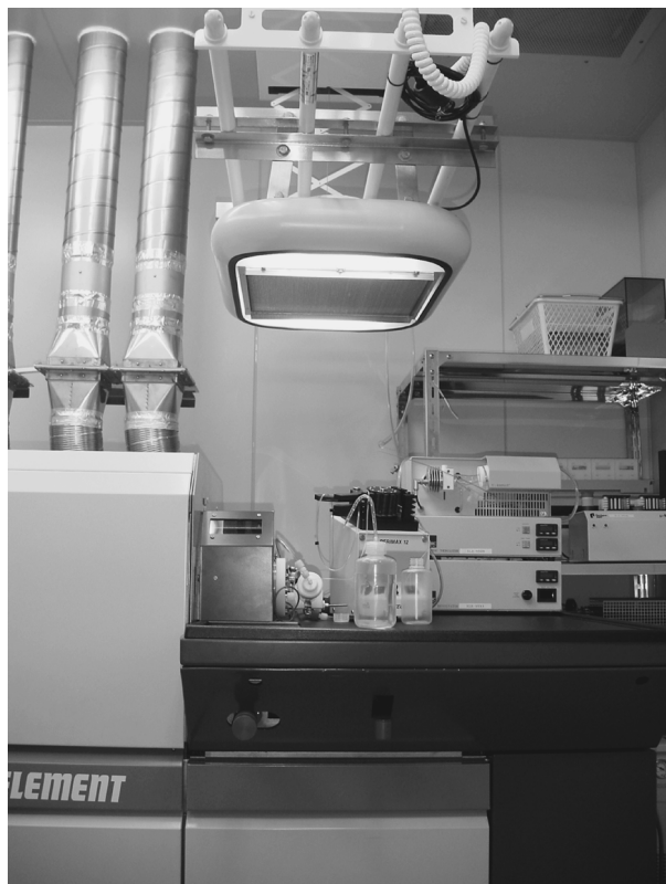
図5 試料導入部の直上に吊り下げたクリーンユニット
